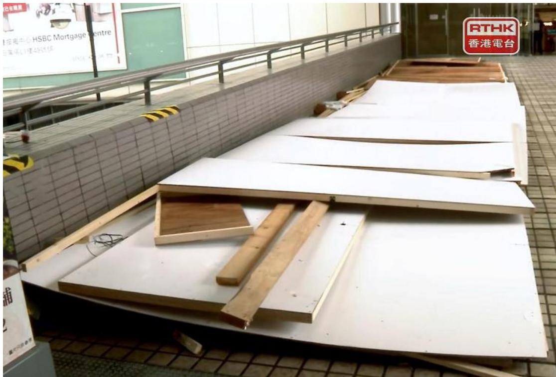
圖 1.2 二零二三年四月十九日早上沙田有圍板被猛烈陣風吹倒，造成 6 人受傷。(鳴謝香港電台提供相片)
