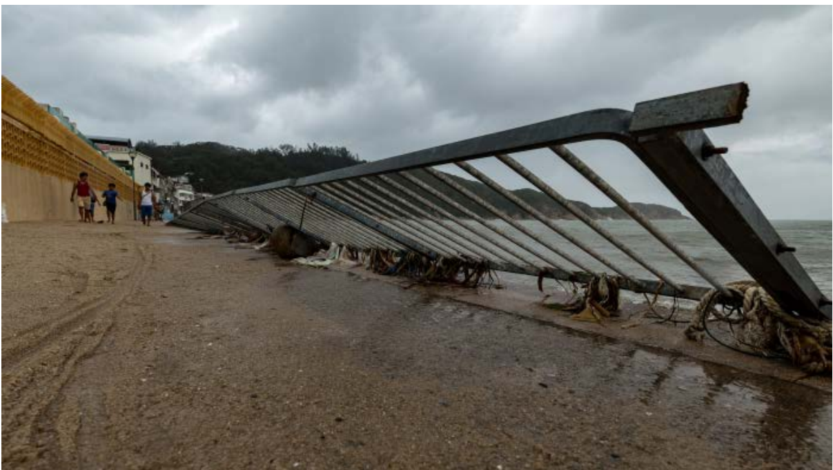
圖 3.3.19b 長洲東灣一帶的圍欄被海浪破壞。(圖片鳴謝: Remington Yu (社區天氣觀測計劃))
