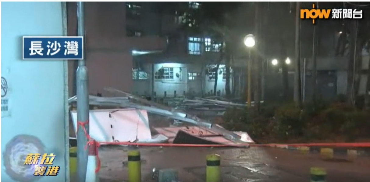
圖 3.3.12 蘇拉襲港期間，李鄭屋邨有大廈天台的太陽能板被強風吹跌至對開的道路。(鳴謝：Now新聞)
