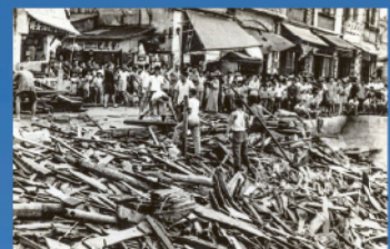
瑪麗吹襲期間，長洲岸邊受到嚴重破壞（岑智明先生圖片）。 Typhoon Mary caused severe damages to the coast of Cheung Chau (photo courtesy Mr Shun Chi-ming).
