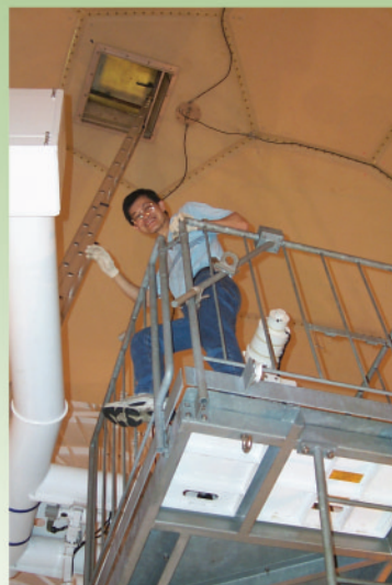
在高台上進行維修工作 Performing maintenance work on an elevated platform
